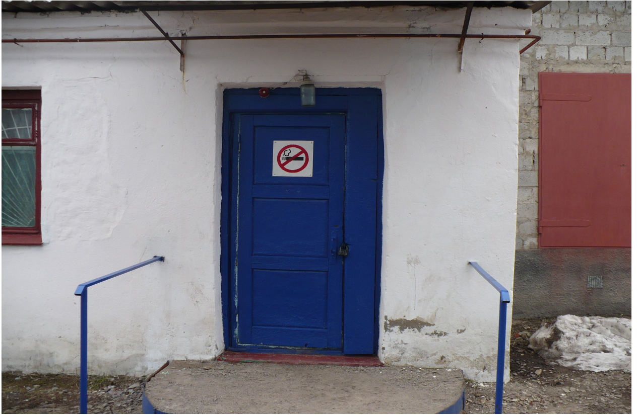
Фото № 5, Дверь входная
