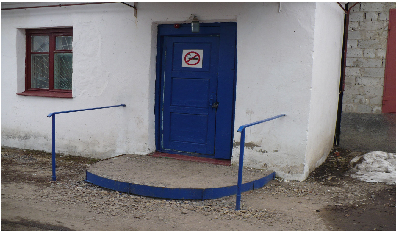
Фото № 4, Входная площадка
