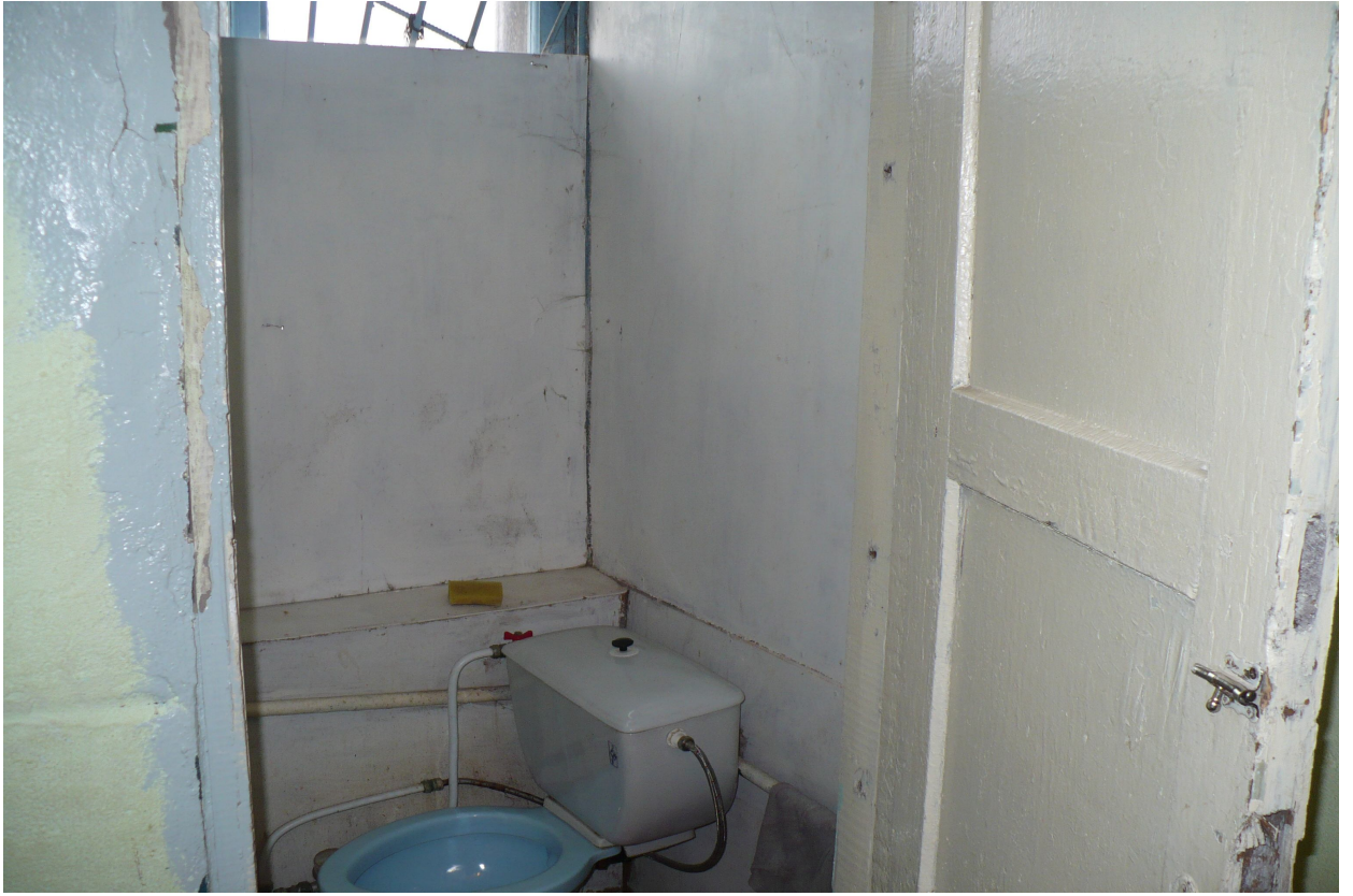
Фото № 9, Туалетная комната
